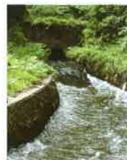
稲生川天狗山穴堰 (トンネル水路)
