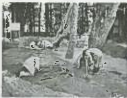
もみじの根元の掘り起こし作業
