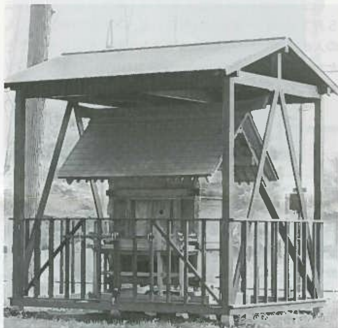
▲修復され新しい鞘堂がかけられた「照瑠堂」
