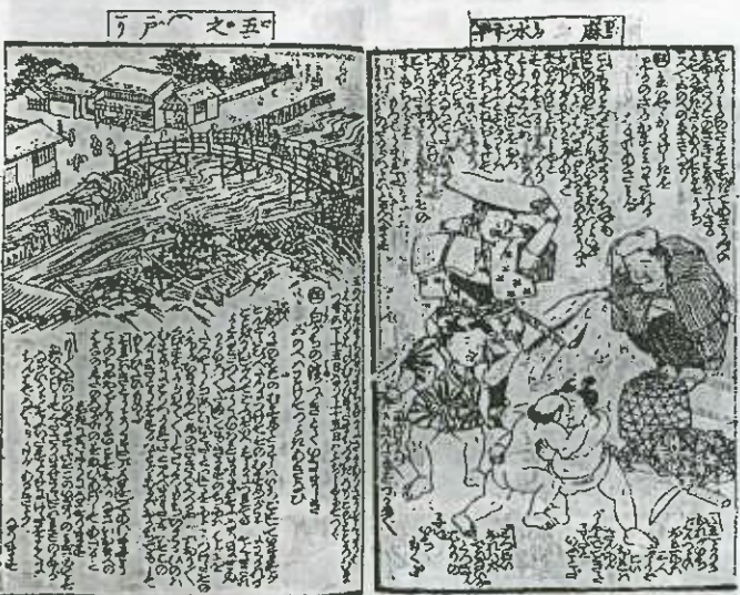
▲浅水～五戸 「五戸よき町なり、町なかに坂あり、坂を下りて橋あり(五戸川にかかる橋)橋のむかいまた町つぎなり」と坂の多い町中の様子を書いていきます。
