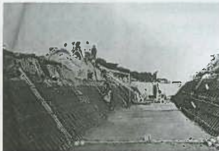
国营開墾事業の▶ 稻生川用水路巻き立て工事の様子。 (昭和14年頃)
